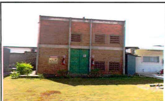
SUBESTAÇÃO DE ENERGIA
