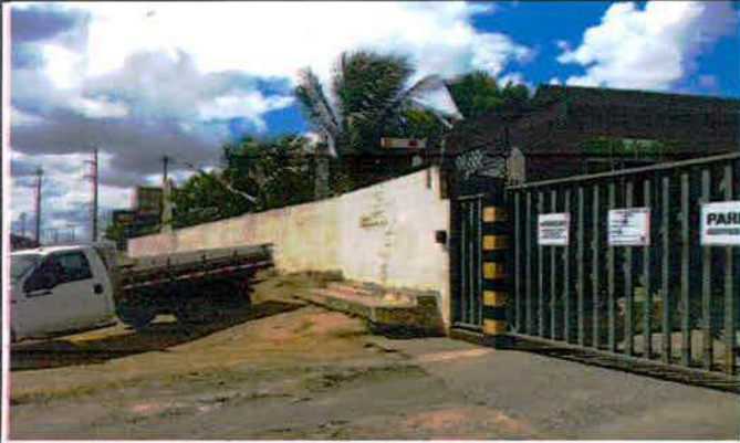
PORTÃO DE ENTRADA
