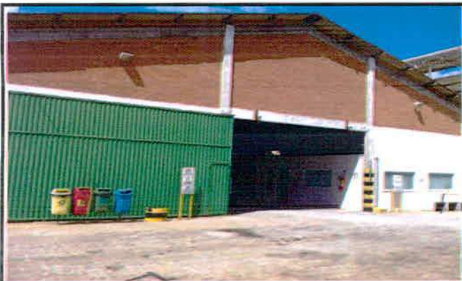
GALPÃO DE ARMAZENAMENTO E EXPEDIÇÃO
