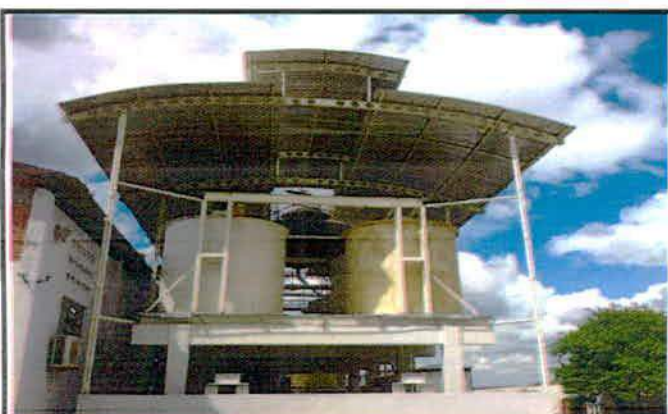
GALPÃO DE PRDOUÇÃO
