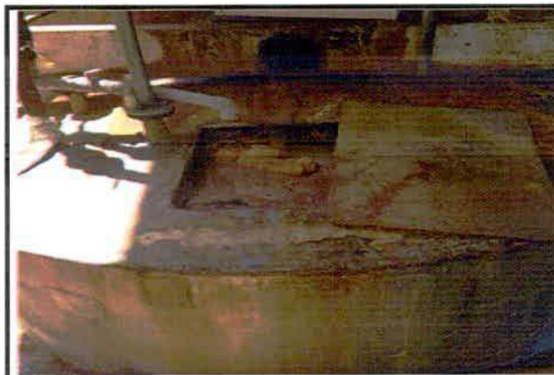
LIMPEZA DO EXPURGO DA ÁREA DA ETE
